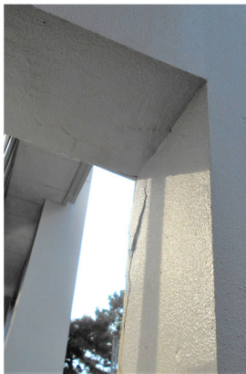
外壁のひび割れ ※ 現在は補修済み
