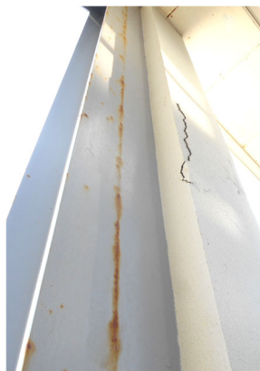
外壁のひび割れ ※ 現在は補修済み
