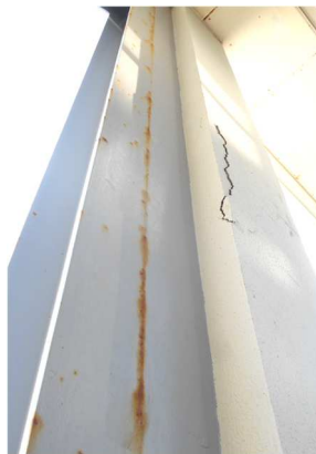
外壁のひび割れ ※ 現在は補修済み
