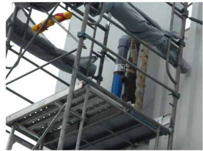
配管設備の老朽化
