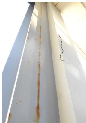
外壁のひび割れ ※ 現在は補修済み
