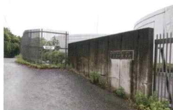
図2 上吉沢配水池(2026年6月28日撮影)
