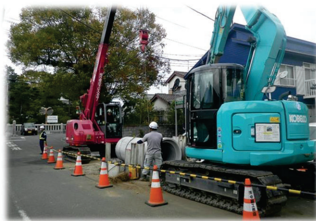
公共下水道工事
