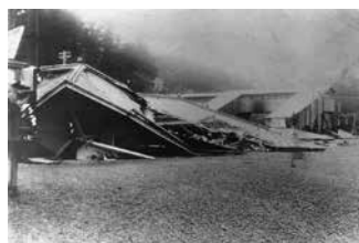
◀関東大震災で倒壊した大磯駅(郷土資料館蔵)
