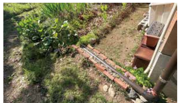
雨水は排水せず庭に浸透させる
