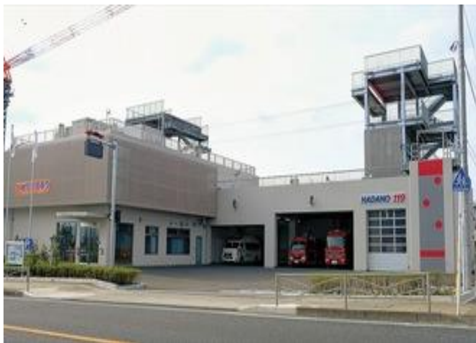
秦野市消防署西分署（分署員32名）訓練塔付庁舎
