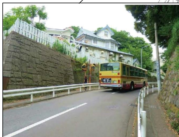
車道が狭く、バスの交互相行が困難となっている。
