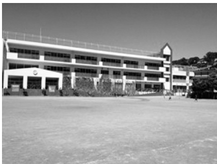
エアコン設置の大磯小学校
