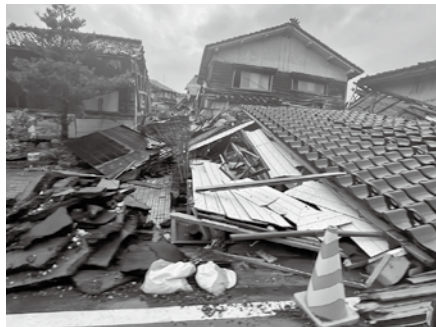
能登半島地震の倒壊家屋状況
