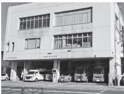
大磯町消防署・消防本部
