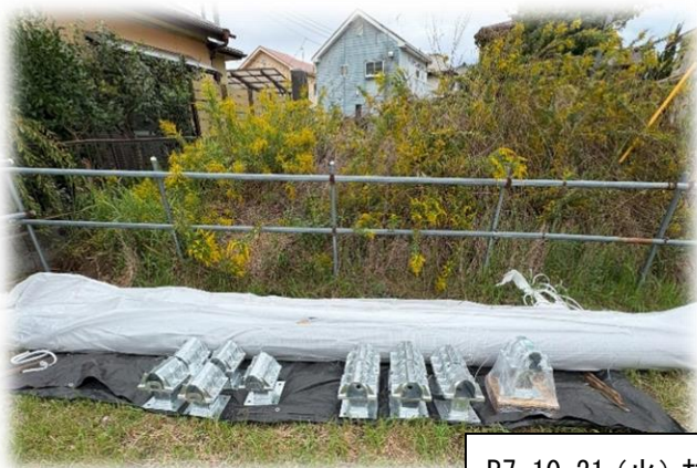
R7. 10. 21（火）材料検査（鋼管柱）
