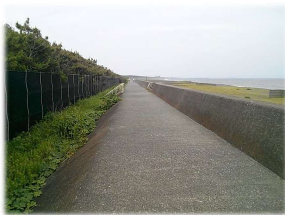
「高潮・津波に備える防潮堤」
