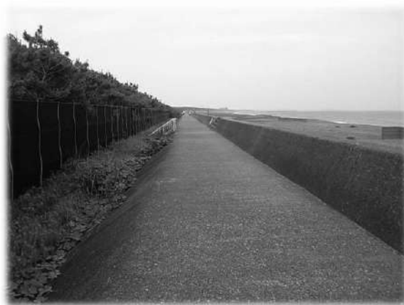
「高潮・津波に備える防潮堤」
