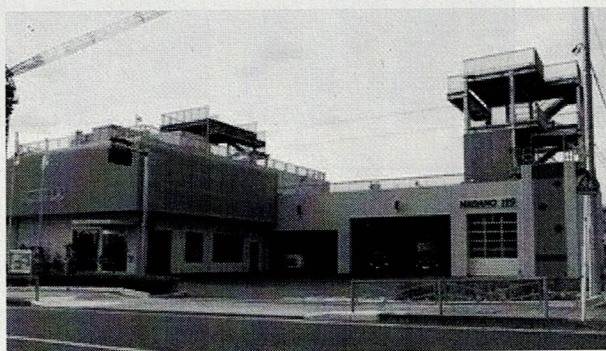
秦野市消防署西分署(分署員 32 人)の訓練塔付庁舎 (同市ホームページより)
