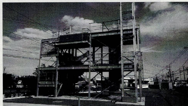
厚木消防署南毛利分署(分署員 21 人)の訓練塔
