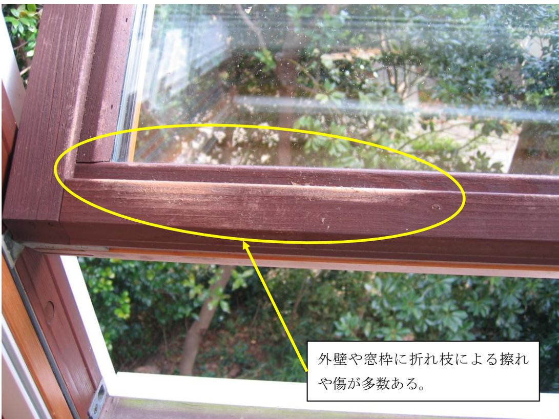
外壁や窓枠に折れ枝による擦れや傷が多数ある。
