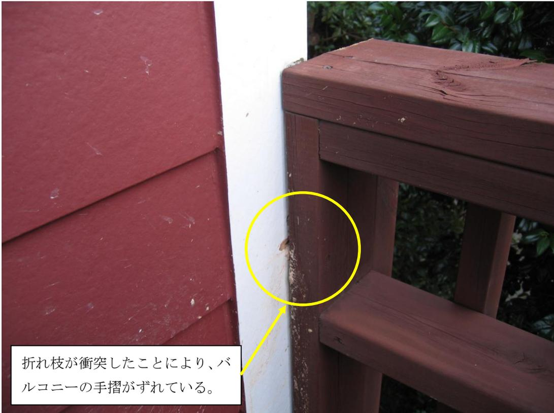
折れ枝が衝突したことにより、バルコニーの手摺がずれている。
