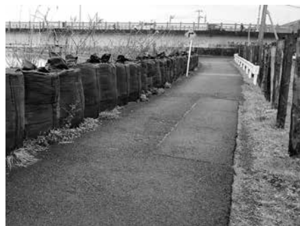
土のうが並ぶ川岸
