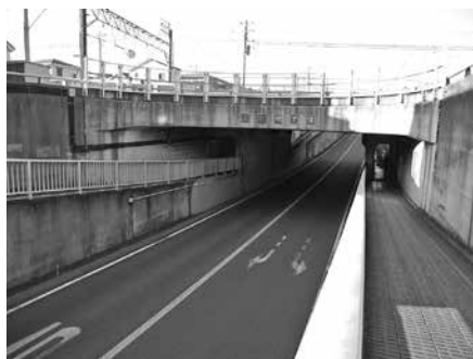
「冠水が絶対ない」と言えない国府地下道
