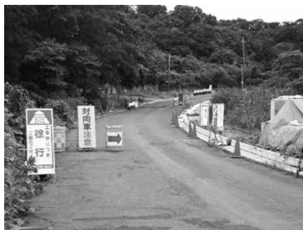
9.5mに拡幅中のマリア道
