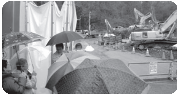
リサイクルセンター建設予定地(既存施設解体中)
