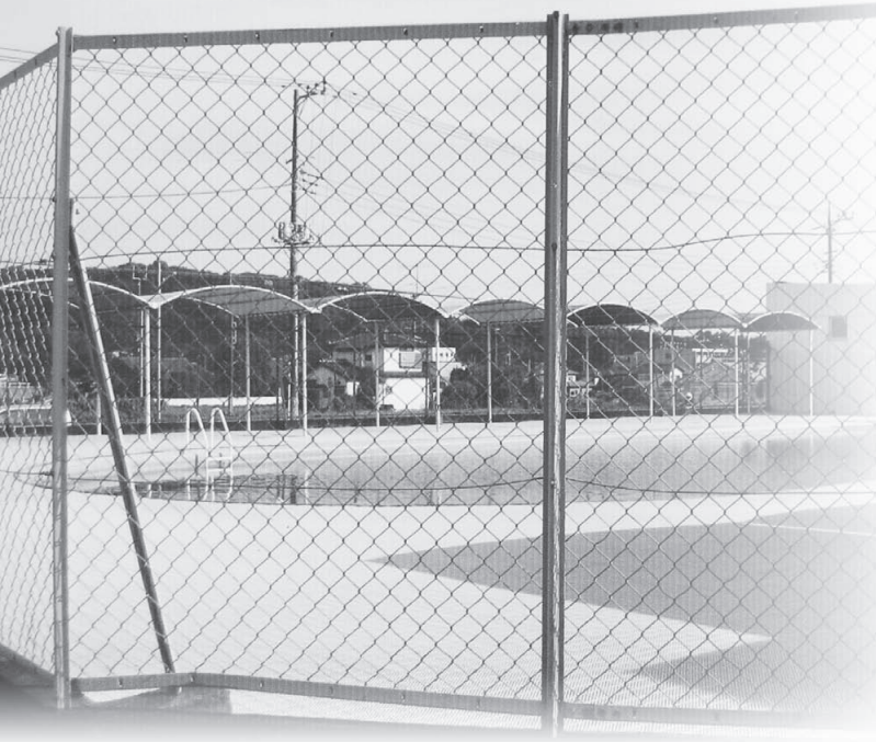
廃止された生沢プール
