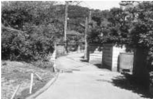
国府地区の未整備道路
