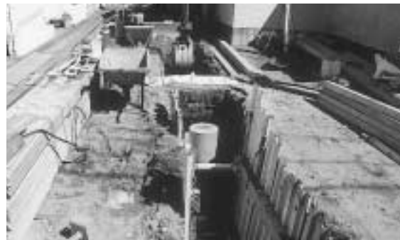
現在進行中の下水工事
