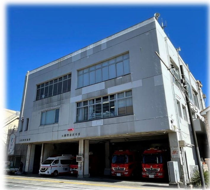
老朽化が進む消防庁舎
