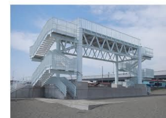
14 津波避難タワー
