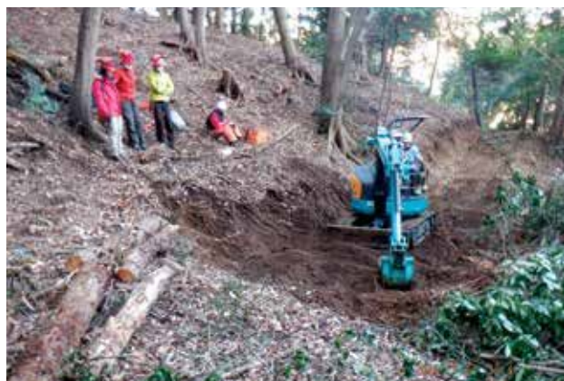
林業研修（作業道実習）
