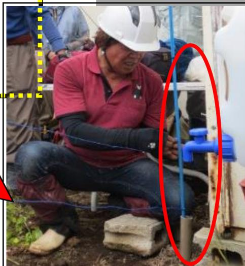
出入口は、電線をつなげたポールを地面に埋めた塩ビ管に差し込み、抜き差しできるようにすると、簡単。
