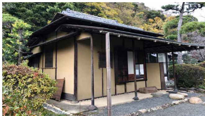
■茶室の外観(南西側より)。屋根:入母屋柿葺、外壁:土壁。雨樋に竹を使用。
