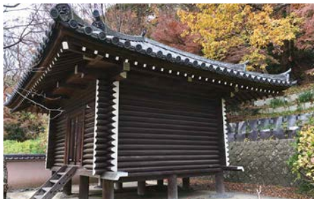
② 経蔵 意匠は安田靱彦画伯によるもので、奈良時代の正倉院の校倉造り(あぜくらづくり)を手本に1931年(昭和6)建造され、中には善次郎ゆかりの品々が納められています。(6坪)
