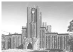
東京大学大講堂(通称:安田講堂) 竣工:1925年(大正14)
