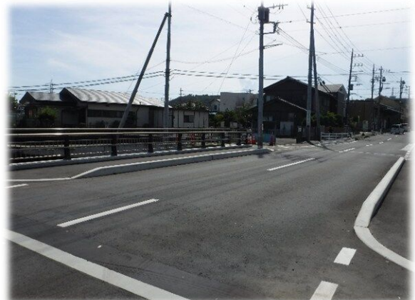
「国府橋の拡幅」
