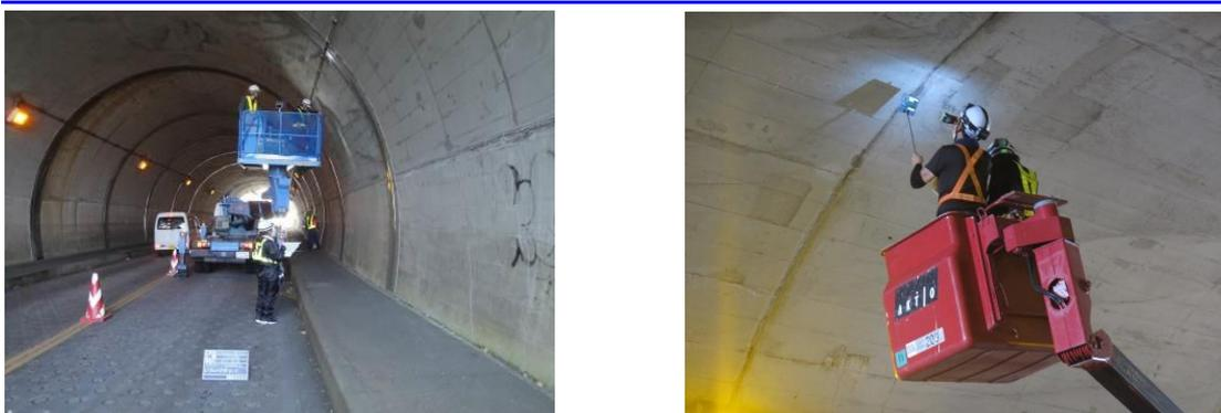
写真 6-1 トンネル点検状況
