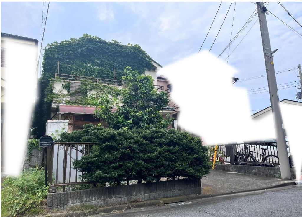
前面道路南西から
