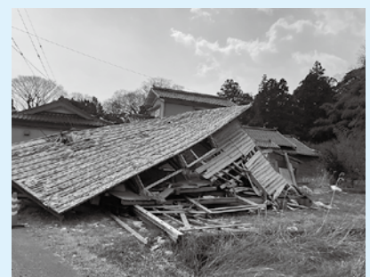
能登半島地震での被災状況
