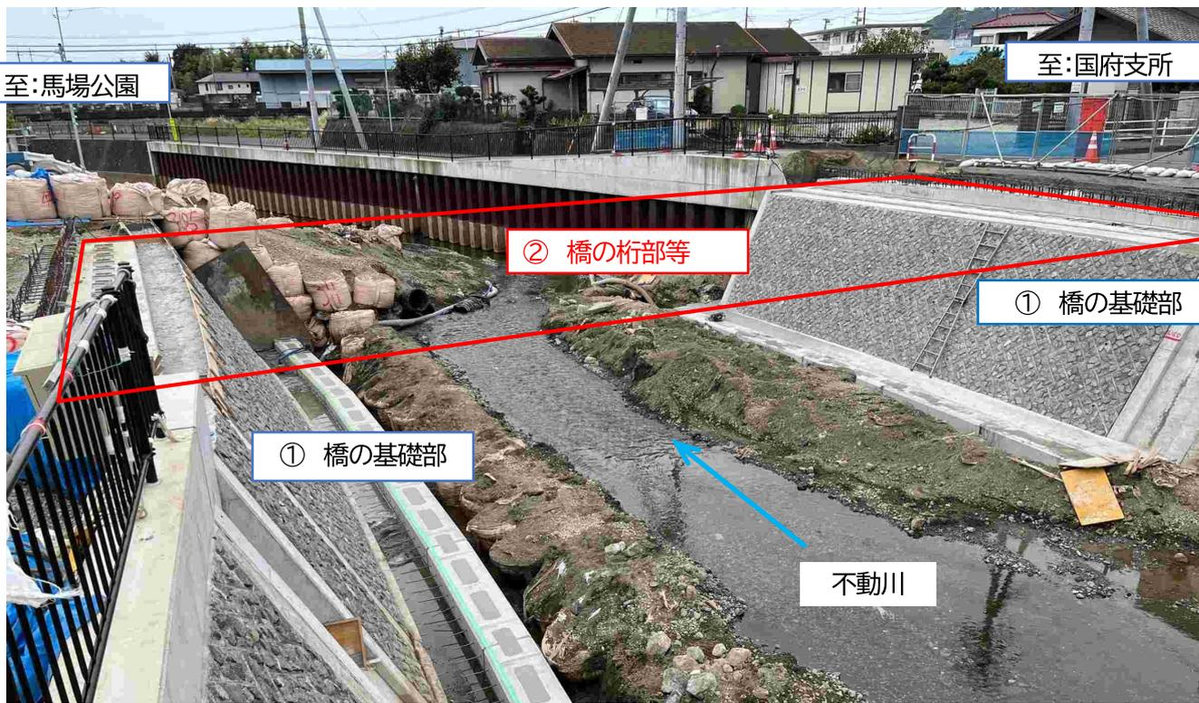
① 令和6年10月で下部工事(橋の基礎部分)及び護岸工事が概ね完了いたしました。
