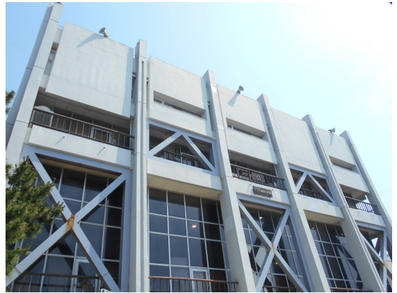
本庁舎の耐震ブレース
