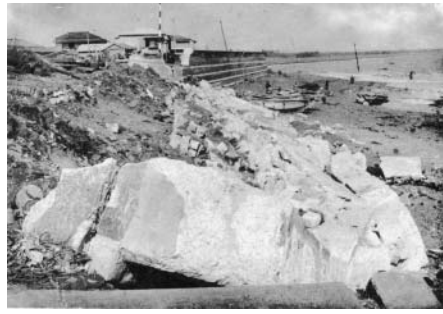
▲関東大震災で堤防が倒壊した大磯海岸 (大震災記念写真帳より)
