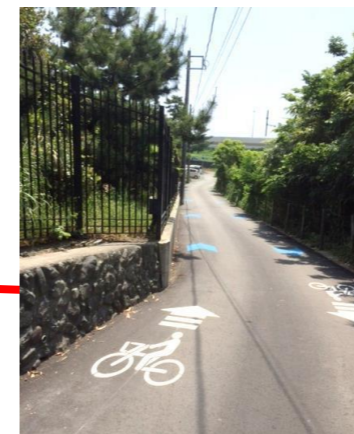
国府本郷23号線整備工事
