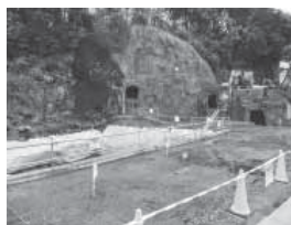
▲再建現場(本邸跡地)
