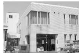
▲国府分館(国府支所内)
