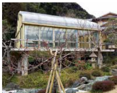
旧吉田茂邸サンルーム (昭和38年建築)
