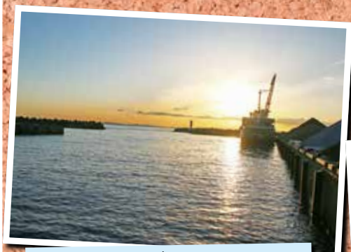
① 照ヶ崎海岸からの夜明け 1/25 高田さん撮影(大磯港)
