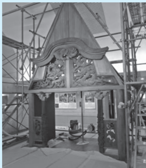
▲再現展示の工事作業の様子
