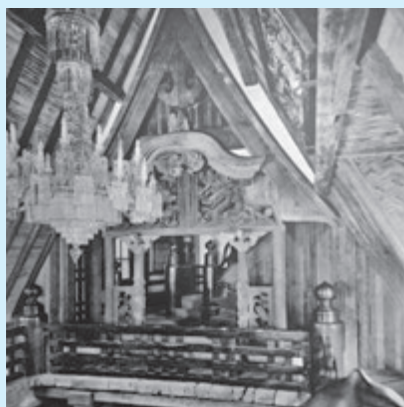
▲かつての城山荘本館 広間吹抜上部 (写真集城山荘より)
