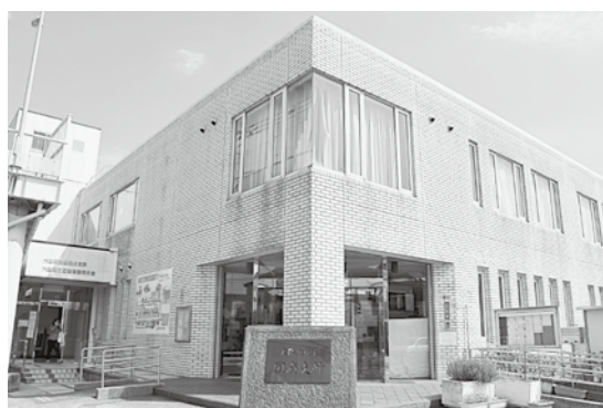
▲耐震化を行う国府支所
