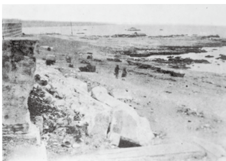
▲隆起した海岸（「震災記録」より／図書館所蔵）
