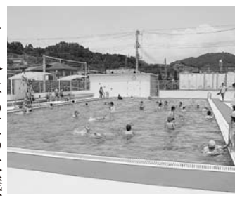
▲完成した国府小学校プール
