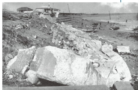
▲関東大震災で堤防が倒壊した大磯海岸(大震災記念写真帳より)
