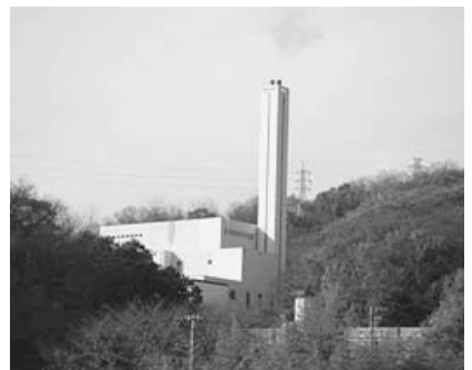
▲ごみの減量が急務の環境美化センターごみ処理施設
