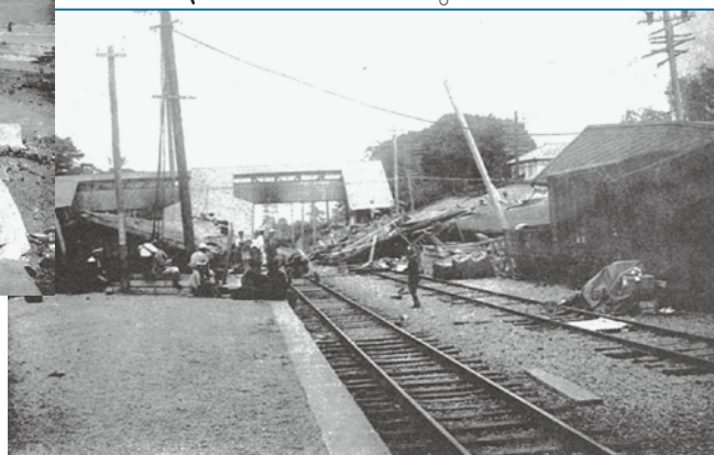
◀関東大震災で倒壊した大磯駅 「震災記録」大磯警察署1924(大正13)年刊所収
