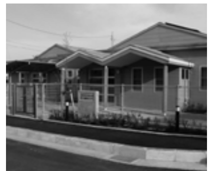
▲完成したセンター正門
