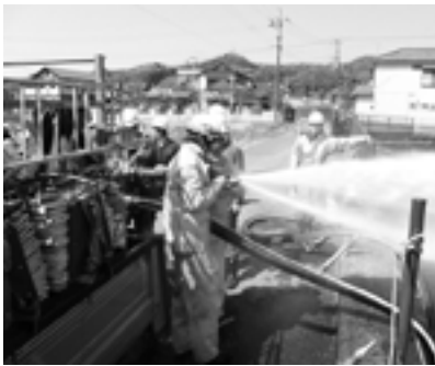
▲放水量検査を行う様子
