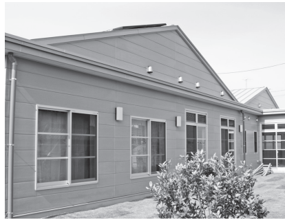
▲完成した子育て支援総合センター
