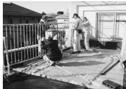
▲屋上フェンスの下地作業をする町内会の方々
