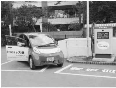
▲急速充電器を設置した本庁舎駐車場
